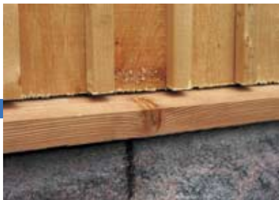
Veelaud vana maja püstvoodri ja sokli vahel. Selline vahe tagab küll märgunud lauaotste taaskuivamise, ent ei taga fassaadi piisavat tuulutust, tuulutuspilu laius peaks olema 20...25 mm. Võimalik on lisatuulutus veelaua alt.
