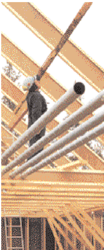
Läbi Masonite'i talade saab vaevata paigaldada näiteks kütetorusid.
