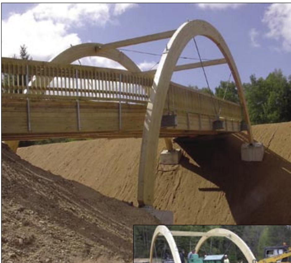
Tehvandi rolleriraja sild. Silla kandevõime ei tekita ilmselt kahtlust. Kaarsild, millele toetuvad pikitalad ja dekilaudis. Katteks on asfalt.
