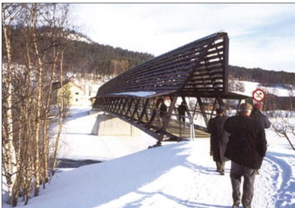
Kreosoodiga immutatud ruumistest sõrestikest sild Osis on hea näide arhitekti ja inseneri mõtete ühendamisest.
