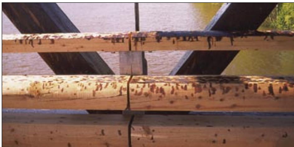
Kreosoot on küll tõhus kaitsevahend, kuid võib esimeste suvede kuumusega välja tilkuda
