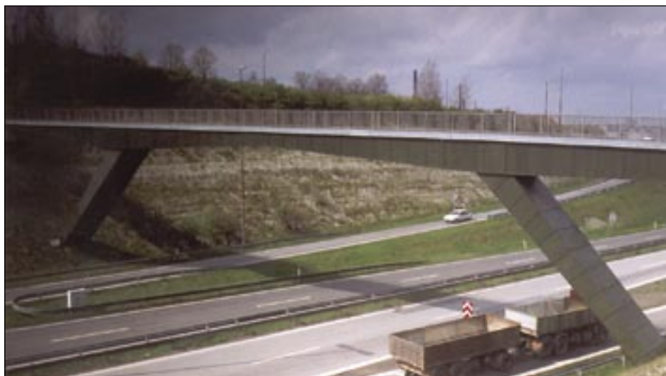
Aalborgi puitsild. Puitelemendid on väljastpoolt kaitstud veekindla vineeriga ja tänu sellele kogu aeg kuivades tingimustes. Ehitusaasta 1968, seni kahjustusi pole.
