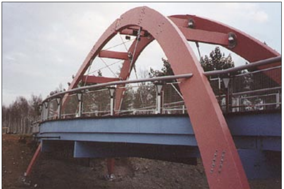
Merirahu sild. Rõduga kaasagne puidust jalgteesild Rocca al Mares. Silla kaari katab viis kihti alküüdvärvi, muud osad immutatud CCA-ga ja värvitud – hea näide konstruktiivsest kaitsest: vesi juhatakse pikikalde ja ääreprusside abil silla otstes olevatesse rennidesse ja seal kanalatsioonini. Äärmiste pikitalade ääres on veekindlast vineerist kaitsefilm. Teras on roostevaba.
