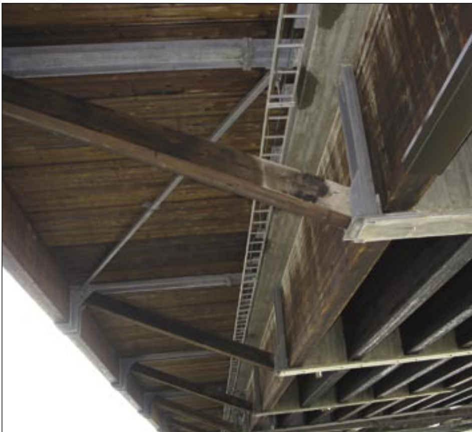
Foto 8. Vihantasalmi silla liimpuidust kandurite ühendamisel on kasutatud betooni ja kuumtsingitud terast.
