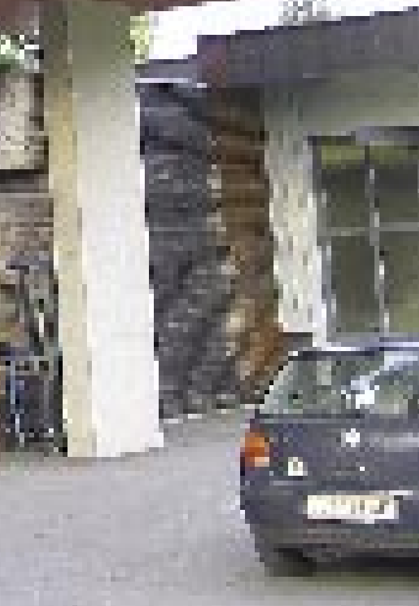
Foto 5. Plaatmaterjali saab fassaadile kinnitada ka silikooniga. Plaat fikseeritakse silikooni kõvenemise ajaks kahepoolse liimteibi ribaga.
