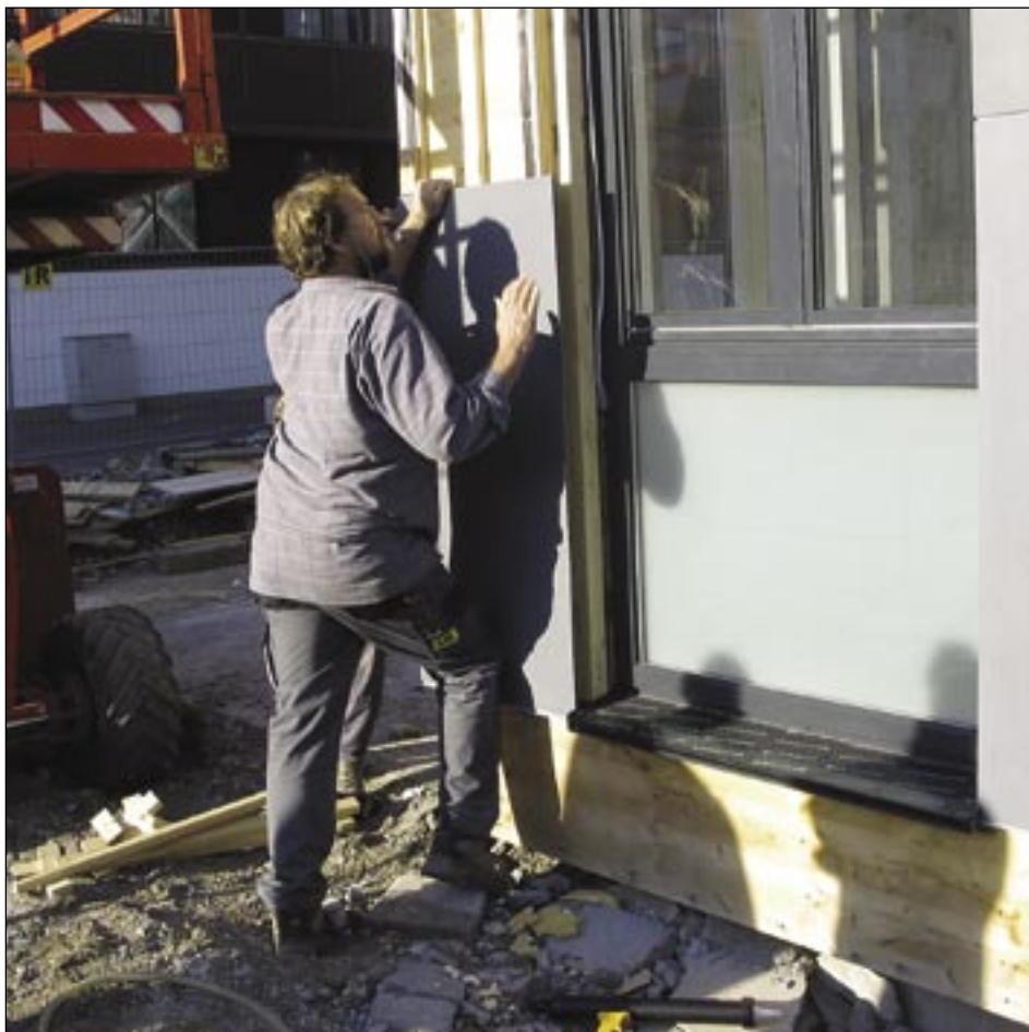
Foto 6. Plaatmaterjali liimimine fassaadile (vt ka foto 4).
