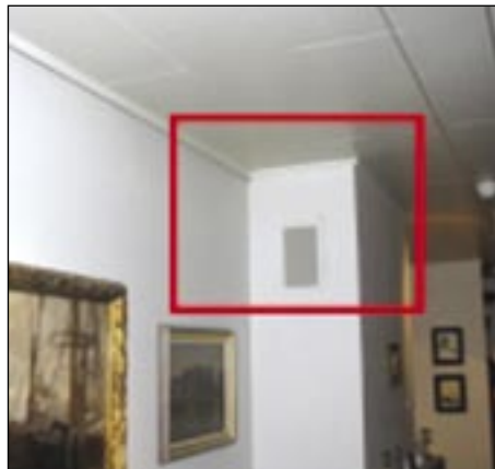
Foto 3. Õhuleke katuslae ja korstna liitekohas. Vasakul mõõtekoht; paremal termograafiline pilt sisemise alarõhu tingimustes.
