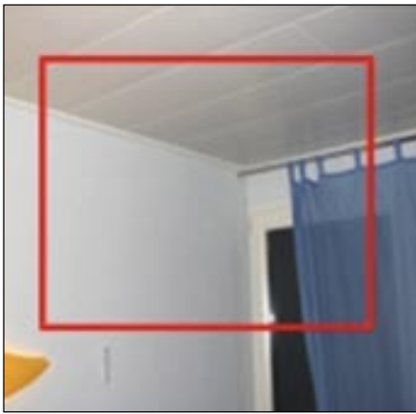
Foto 2. Õhuleke välisseina ja vahelae liitekohas. Vasakul mõõtekoht. Keskul termograafiline pilt ilma õhurõhu erinevusteta ja paremal termograafiline pilt sisemise alarõhu tingimustes. Sinised alad on madalama temperatuuriga. Alajahtumise peapõhjus on õhuleke.
