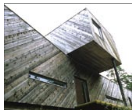
Foto 7. Männilauad on töödeldud rauavitrioli lahusega ja seejärel õlitatud. Sama võtet (ilma õlituseta) kasutatakse ka palkmajadele vanema välimuse andmiseks.
