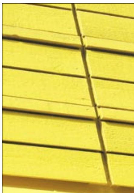
Foto 15. Voodrilaudu saab pikkuses jätkata ka nõnda: liide on jäetud meelega avatuks, et niiskus saaks väljuda.
