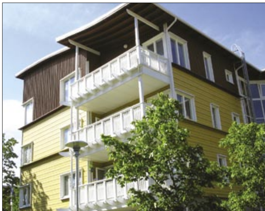
Foto 13. Lahti Puu-Vallila majade fassaadid on detailides väga hästi läbi töötatud.
