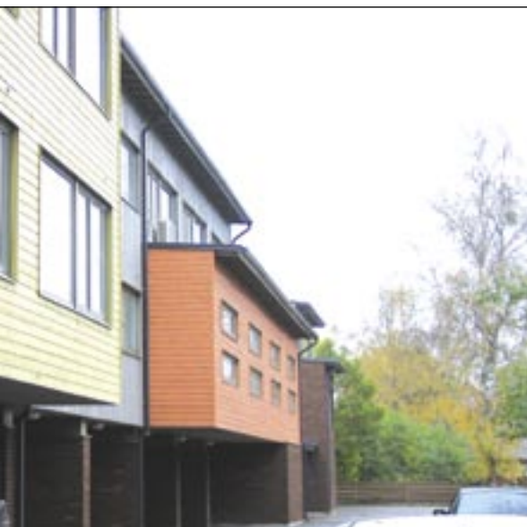
Foto 11. Arhitekt Lauri Saare versioon horisontaalvoodri nurgast on nutikas ja tõhus – plekk + silikooniga kinnitatud latt.
