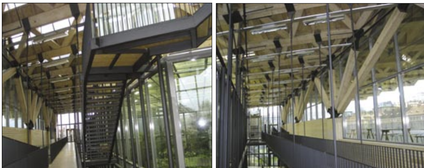
Foto 5 ja 6. Vihmametsa ja liimpuidust tahuka vaheline ala on kogu kõrguses avatud. Treppidelt ja käiguteedelt saab vaadata vihmametsa ja terrassi ning jälgida, kuidas hoone tegelikkuses toimib: kogu konstruktsioon on avatud, inimesi on liikumas nii liftides kui treppidel-vahekäikudes.
