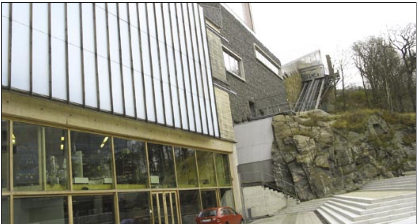
Foto 3. Universeum paikneb mäenõlval. Traatkastidesse pandud graniitkillustikust välisseintega akvaariumiplokist viib ülespoole kaldrööbastel liikuv lift.
