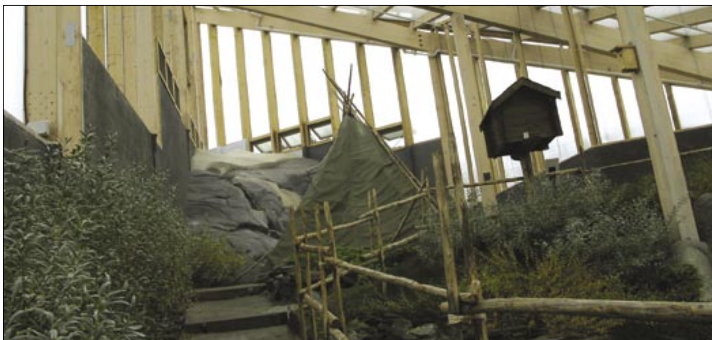
Foto 7. Universeumi ülemine osa on üsna lihtsa konstruktsiooniga. Katusekatteks on vaid polükarbonaat, sest üle kümne soojakraadi pole ruumi vaja.
