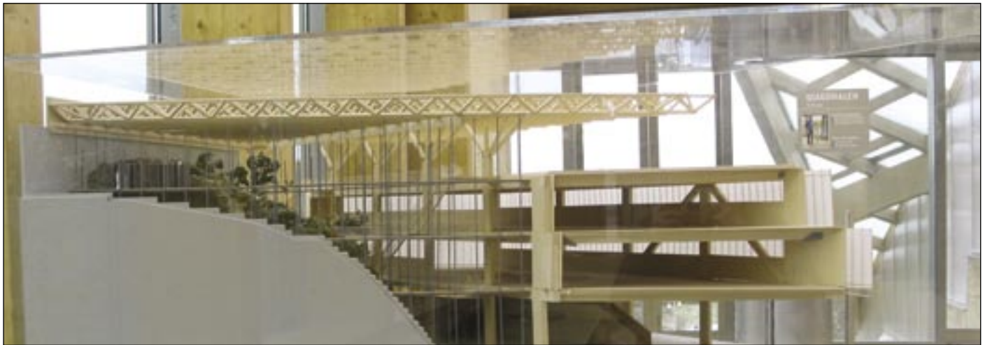
Foto 1. Universeumi vihmametsa sektsiooni (vasakul) ja liimpuidust postide tahukakujulise osa makett. Sörestikfermidest katus ulatub 12-meetrise konsoolina liimpuidust tahuka katusel oleva terrassi kohale. Vihmametsa kohal on talade sille kuni 35 meetrit.
