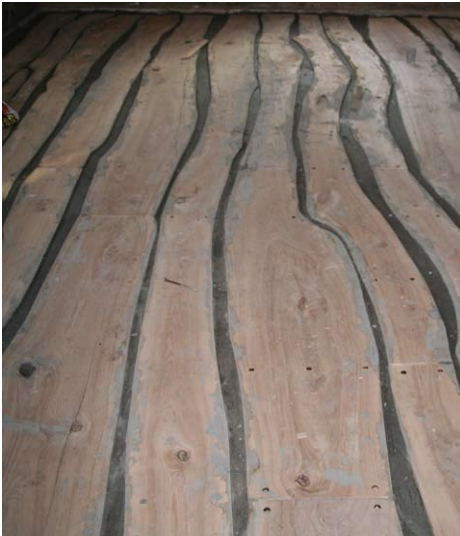
Foto 2. Põrand on paigaldatud, vahed on betooni täis valatud.
