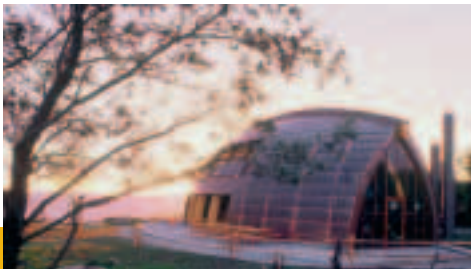
Toitlustusettevõtte Paat Indrek Suigusaar 2001 Liimpuit, ehitis
