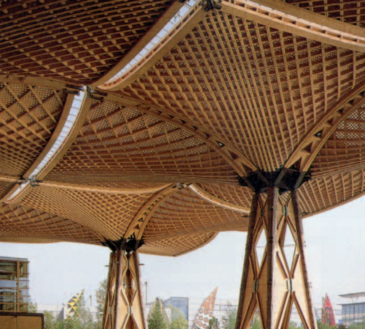
Lainetavat merd kompuuterlikus 3D-tõlgenduses meenutavat pinda kannavad tohutud jalad. Puudega tekkiv sentimentaalne analoogia on ilmne. EXPO paviljon Hannoveris (2000). Herzog & Partnerid.
