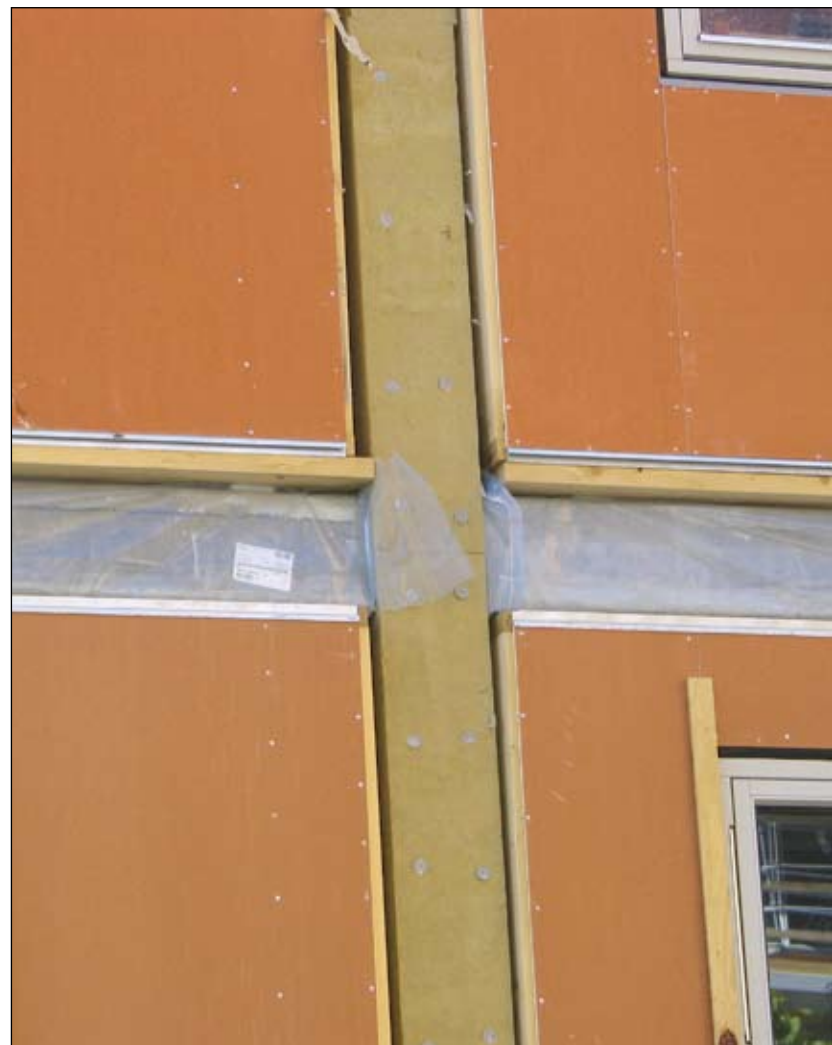
Foto 4. Tehases valmistatud puitkarkasspaneelid monteeritakse betoonkarkassi «sahtlitesse».
