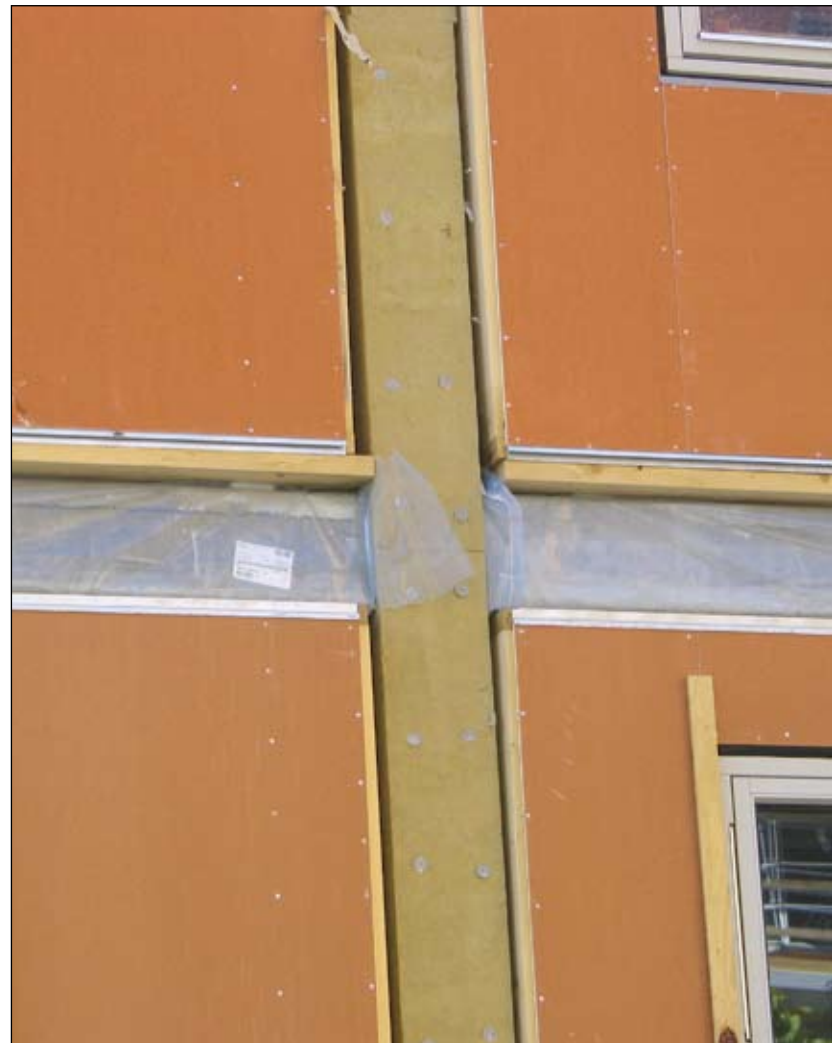
Foto 4. Tehases valmistatud puitkarkasspaneelid monteeritakse betoonkarkassi «sahtlitesse».
