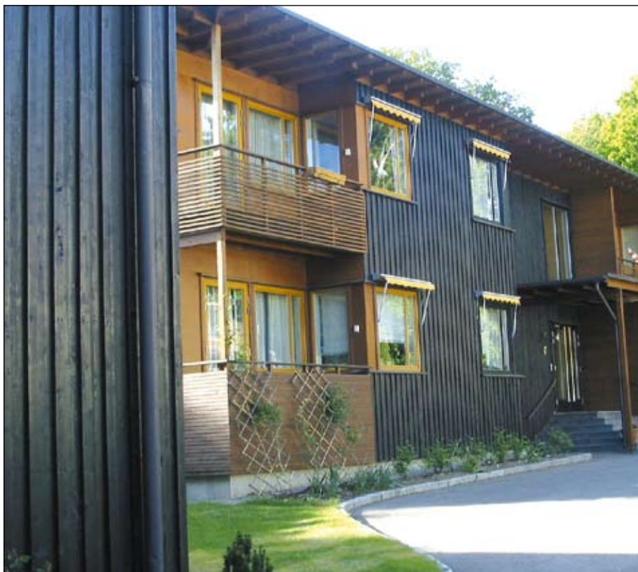
Foto 5. Uute majade fassaadid on sageli tõrvavärviga tumedaks värvitud, mida kinnitab ka sel fotol nähtav kattelaudist.
