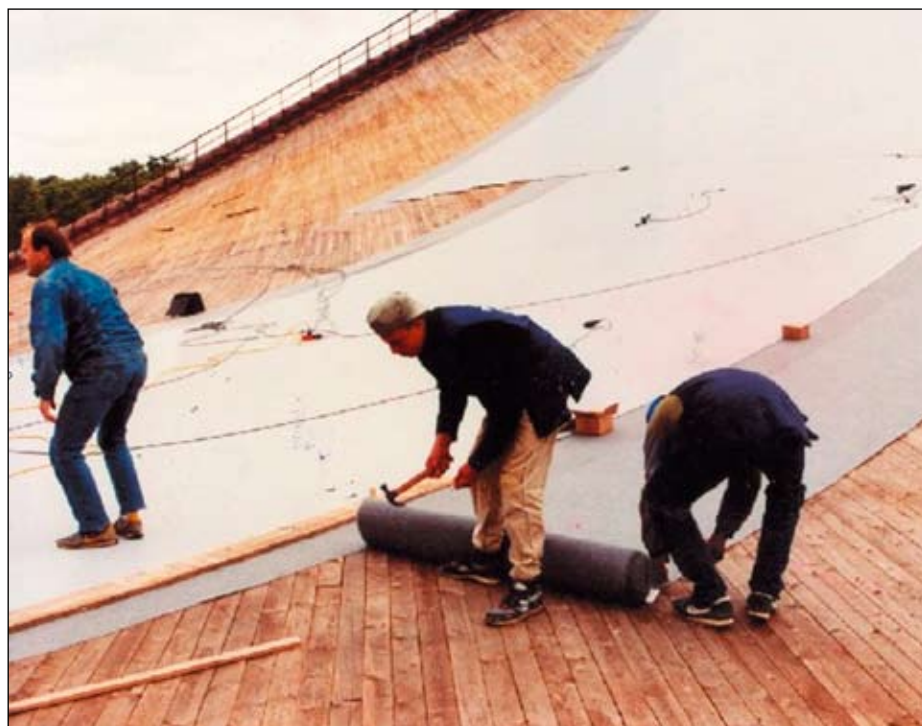
Joonis 14. Tartu laululava koorik(ripp)katuse katmine PVC-kattega.
