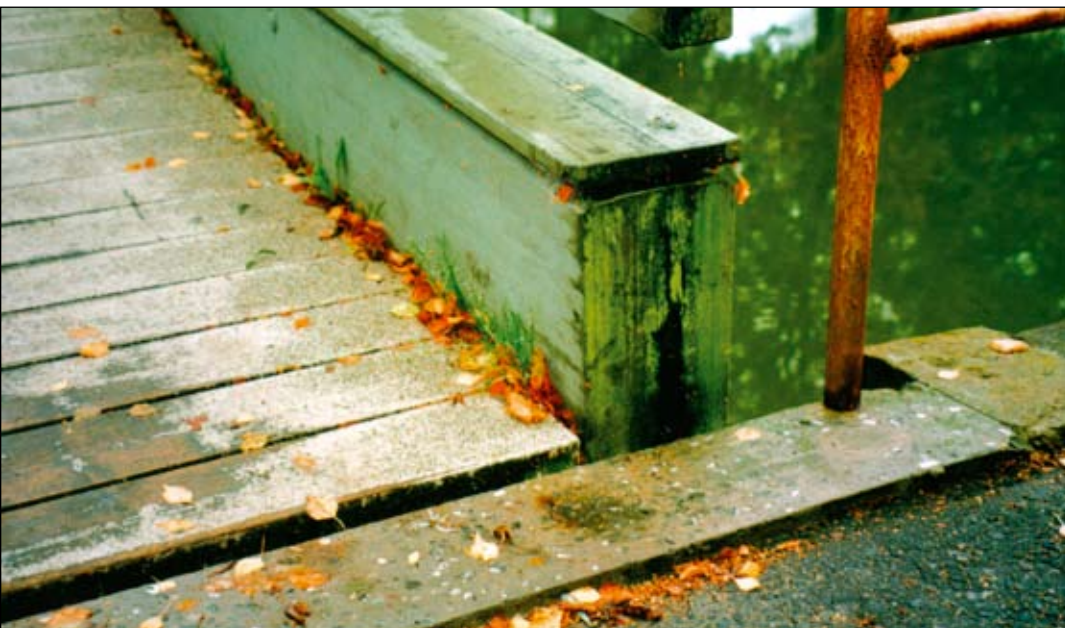
Näide halvasti lahendatud konstruktiivsest kaitsest: konstruktsioonile kogunev prahitakistab konstruktsiooni kuivamist ja loob kasvupinnase puidu mädanemiseks.
