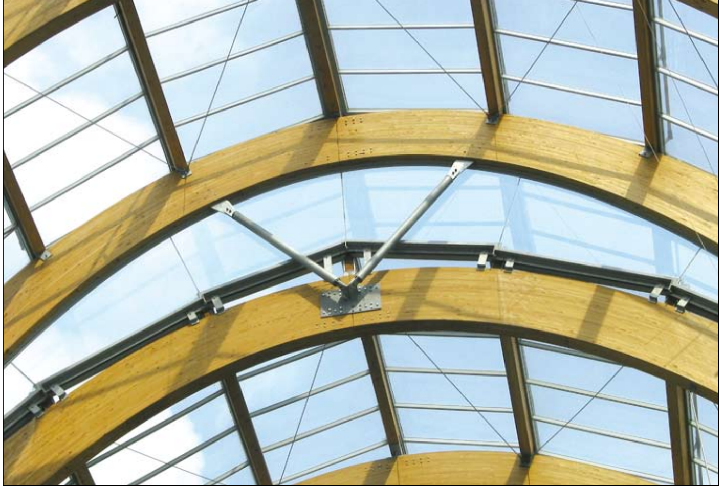
Foto 4. Liimpuidust kaared on eri kõrgusega. Seepärast on hoone välisvaadet võrreldud vahel ka looma selgrooga (vt ka foto 2).
