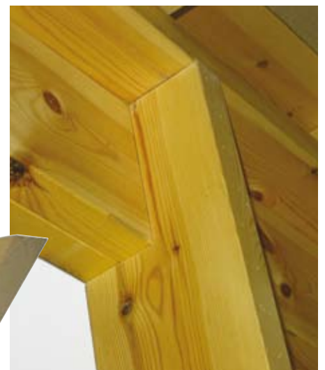
Näide karkassiposti ja vöötalade ühendusest. Postide tugikohtadesse freesitakse väikesed pesad, mis teeb postide asukoha määramise mõõtmise teel tarbetuks.
