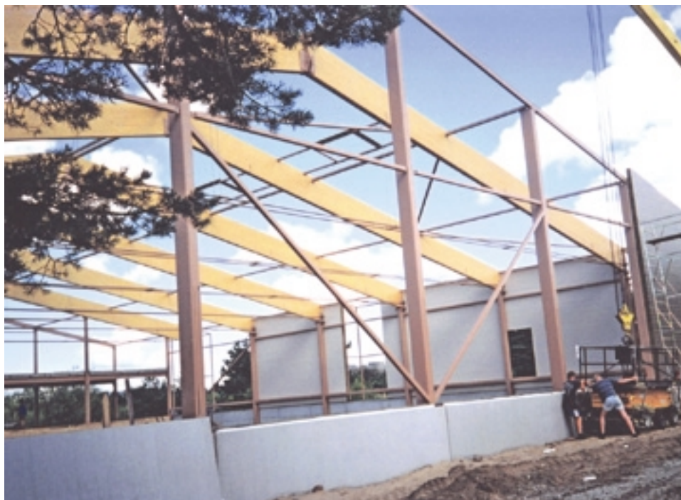
Tiit Soku korvpallikooli katust kannavad liimpuidust fermid.
