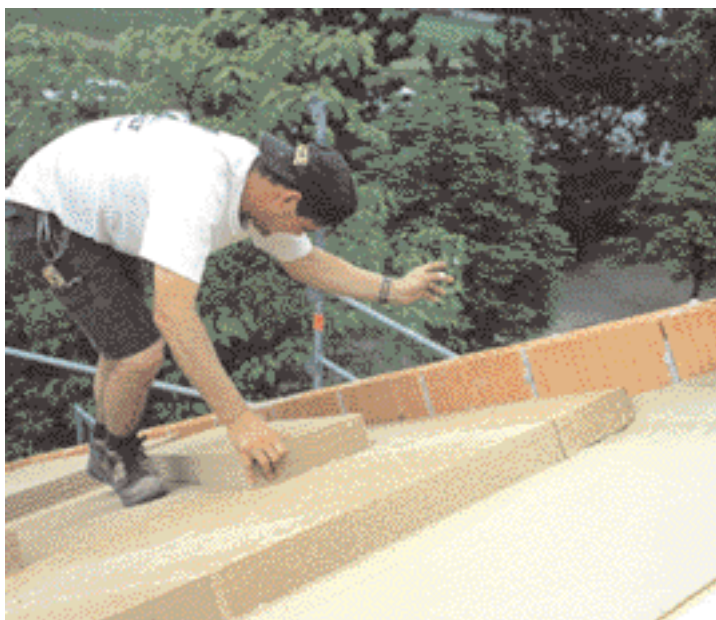
Isoleerplaat Pavatherm, materjal Pavaflex DSB 2 ja alusplaat Isolair moodustavad katusel ideaalse roovidepealse isolatsioonilahenduse.
