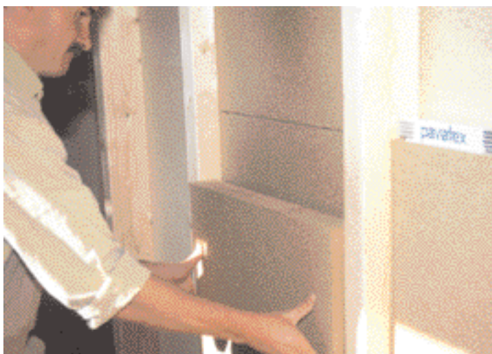
Tugipiilarite vahele paigaldatav puitkiudplaat Pavatherm suurendab oluliselt puidu osakaalu majas.
