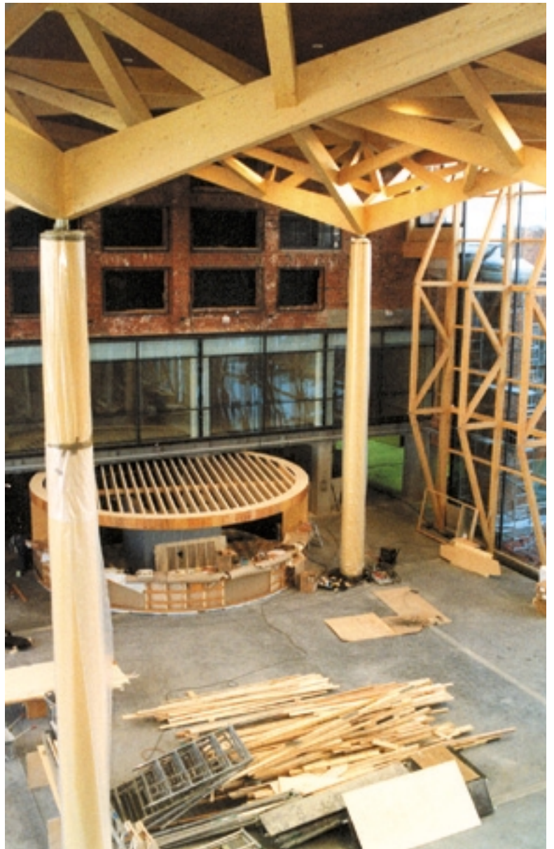
Metsahalli sisevaade ehituse käigus. Taamal tehase sein.
