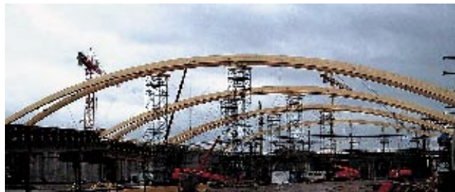
Karlsruhe messihallide montaaž
