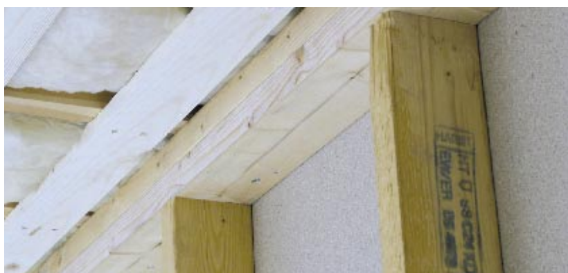
Eesti projekteerimisnormide järgi peab puitkarkassis kasutama tugevussorteeritud puitu.
