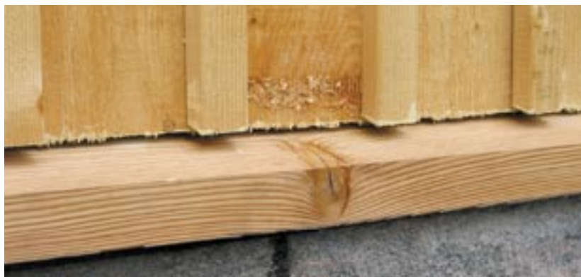
Õhuvahel voodrilaua alumiste otste ja soklilaua vahel laseb niiskusel puidust välja tuulduda.
