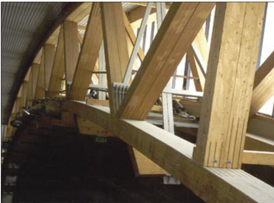
Naagelliide sissefreesitud terasplaatidega. Kinnititeks koonilise otsaga naaglid, mis puidu pinnast välja ei ulatu.
