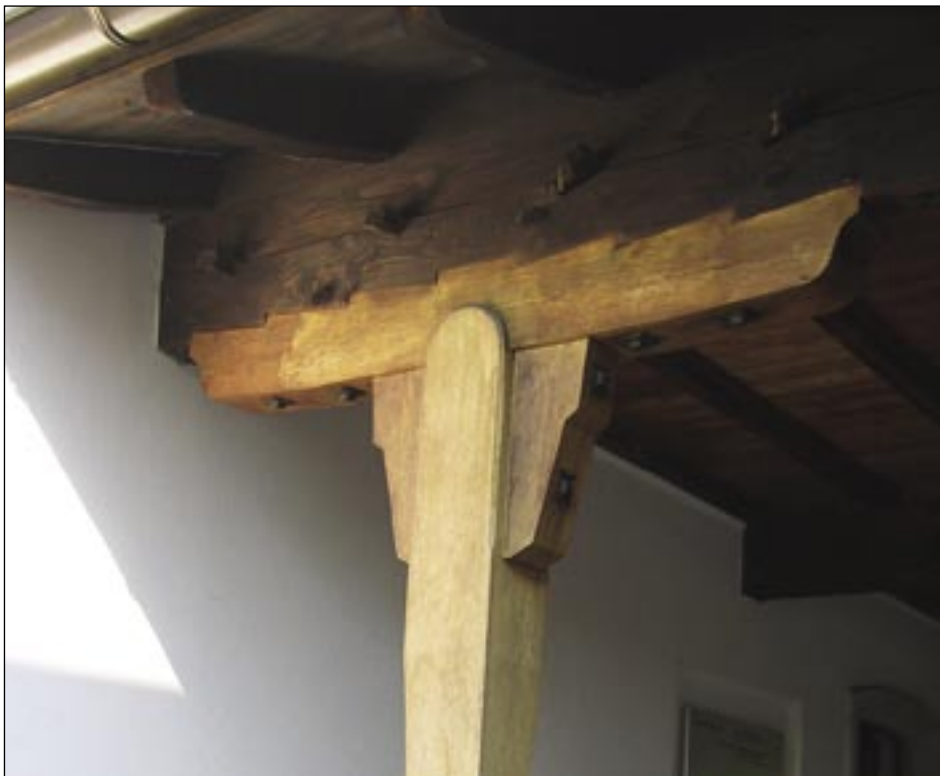
Näide traditsioonilistest puidu liidetest: all tappliide, ülal tüübelliide.
