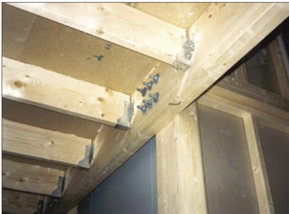
Abitalad on kinnitatud toekingade abil peatalade vahele. Nii saab võita vahelae kõrguses. Posti ja peatala ühendus on poltliitega.
