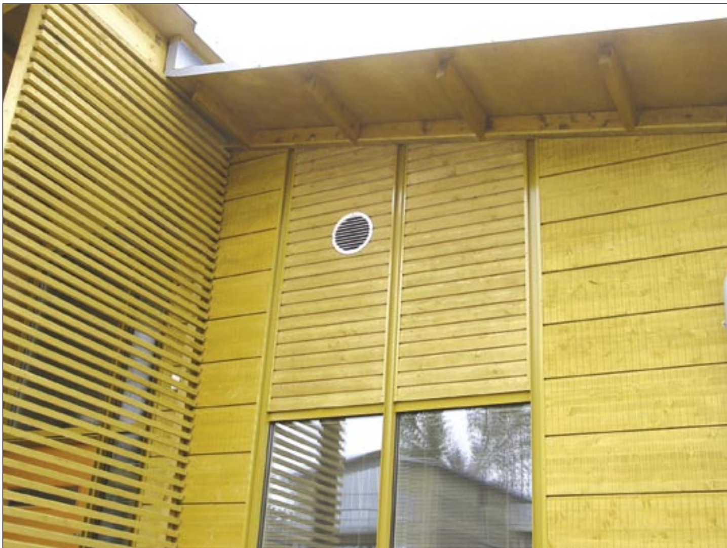
Foto 2 Uudne ca 300 mm liimpuidust välisvoodrilaud valmivas Friisilä elurajoonis Helsingi lähistel. Foto: Märt Riistop
