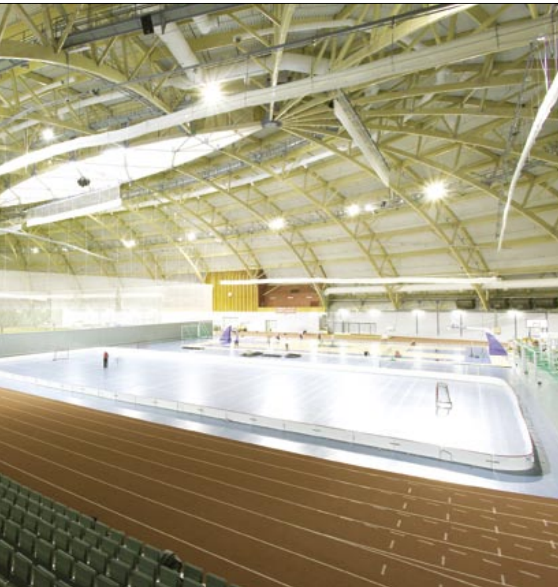
Vastvalminud Joensuu universaalhall on Soome suurim puitehitis, 150 meetrit pikk ja 110 meetrit lai. Hiiglaslik katuseaken on valmistatud spoonliimpuidust ja toetub 28-le liimpuidust sõrestikuga poolkaarele. Foto:Woodfocus OY
