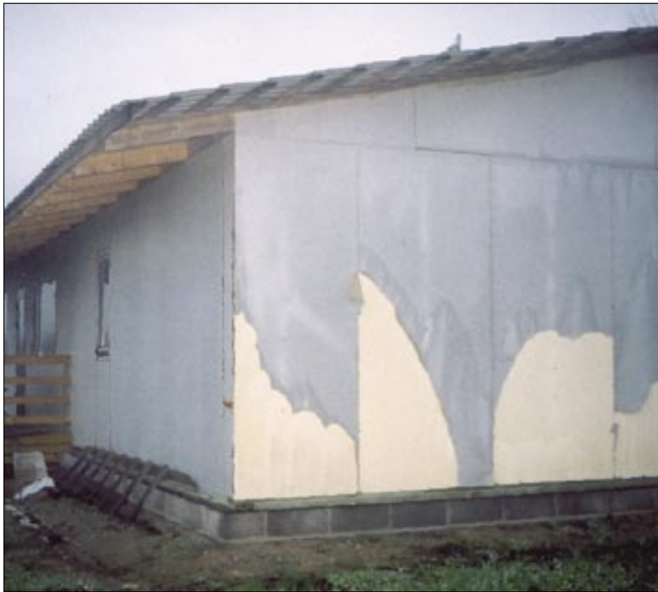
Tuuletõkkeplaat ei ole kavandatud taluma välisvoodrile mõjuvaid vihma- ja lumekoormusi. Tuulutusvahega välisvooder peab olema osa puitkarkasseinast.
