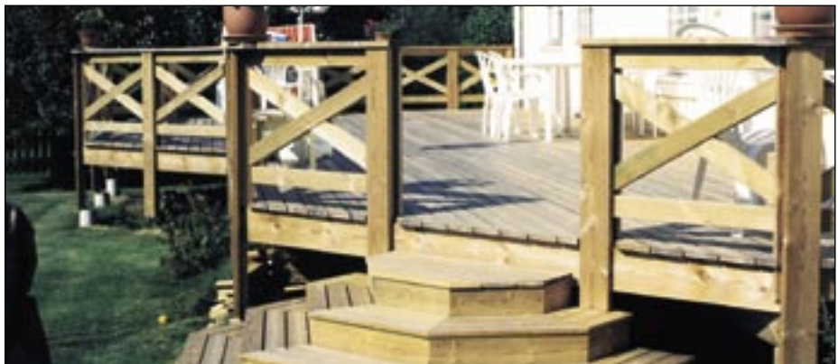
Foto 7. Keerukama konstruktsiooni korral tuleb tugipostid korralikult toetada, et vältida nende ebahühtlast vajumist pinnase külmumise-sulamise tõttu. Immutusvahendeid saab ka toonida, levinuim on pruunikas toon roheka asemel.
