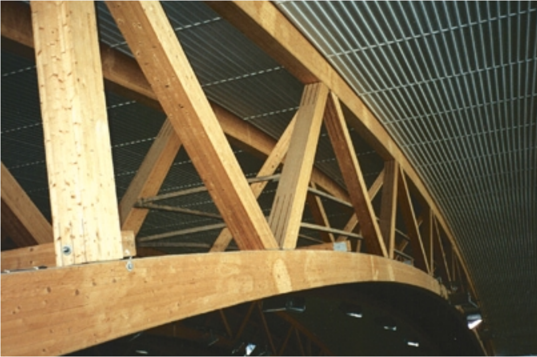
Konstruksioonide tulepüsivus R120 on tagatud piisava ristlõike suurusega.
