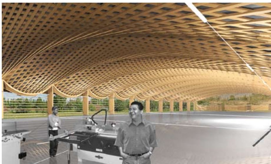
Pilt 2.2. Hüparkoorikute ehituslikke võimalusi: ühekatteliste hüperboolsete osade (joonpinna geomeetria) lõikumisel põhinev konstruktsioon. Puun Talo (Puidu Maja) Kitee linnas. Arhitektuurne lahendus ja kujundus: Pook Arkhitektitöimisto Oy.
