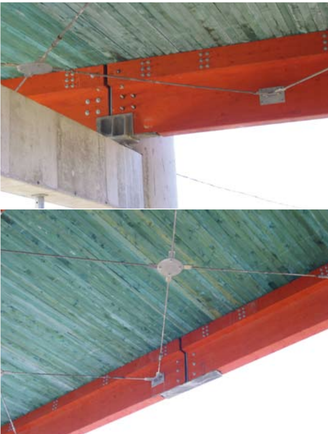
Fotod 2 ja 3. Talade liiteid on kahte tüüpi.
