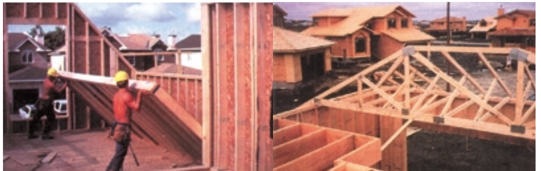
Kanada tüüpiline puitkarkasskonstruktsiooniga elumaja ja selle kokkumonteerimine.
