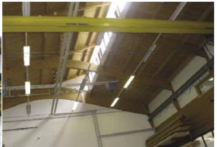
Foto 8. Fotol 7 kujutatud hoone sisevaade. Kuigi tegu on väiketootja väiksemapoolse hoonega, on siingi lennukad liimpuitkaared ja katuseaknad loomuliku valguse saamiseks.
