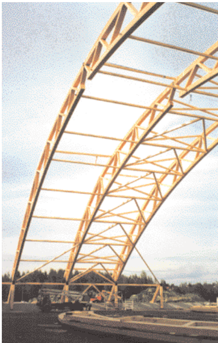
Staadionikatuse kandekonstruktsioon "Pirkahalli" Tampere. (4)
