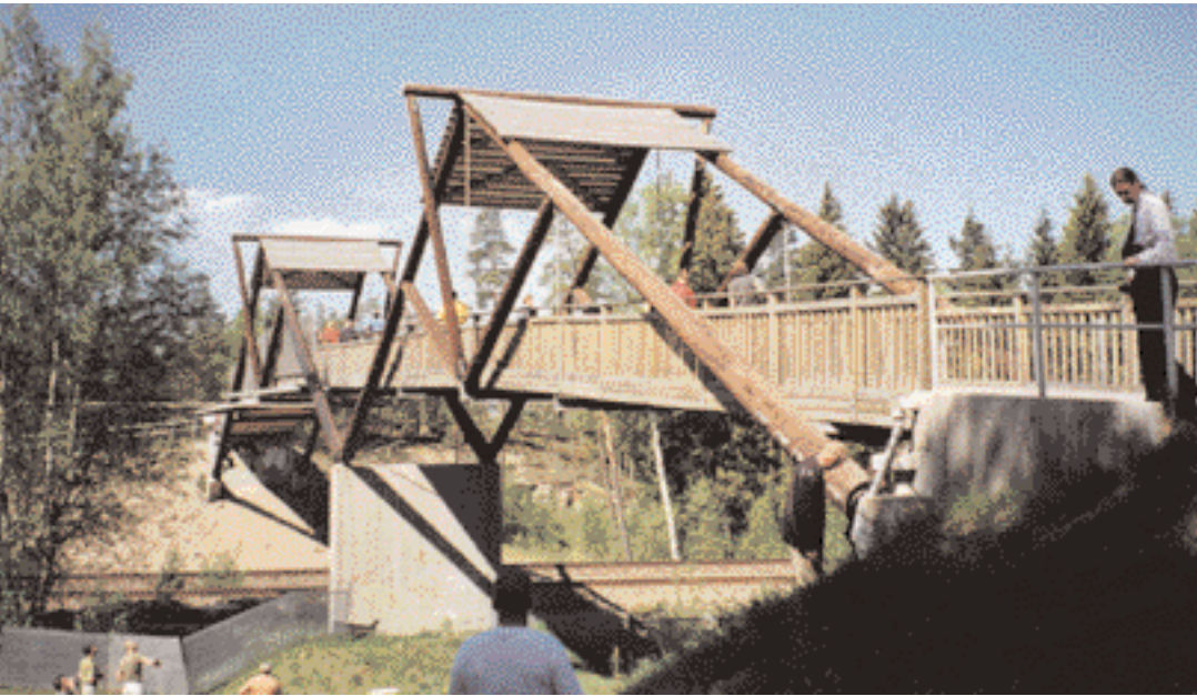
Loodusesse sobiv puidust jalakäijate sild (Soomes). (10)
