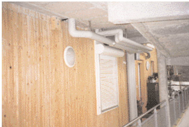
✚ Hoone põhikandeseinad on puit-betoon-puitplaadid.
